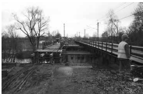
Výměna mostní konstrukce v roce 2008
