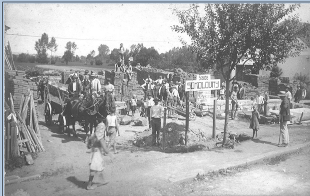
Obrázek 1: Stavba základů Sokolovny, 20. léta 20. století.
