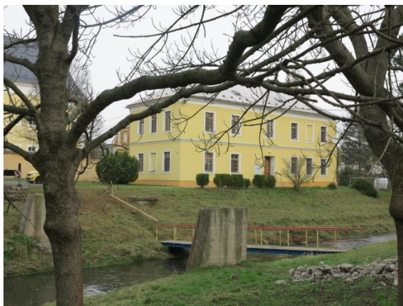
Průběh výměny lávky za novou
